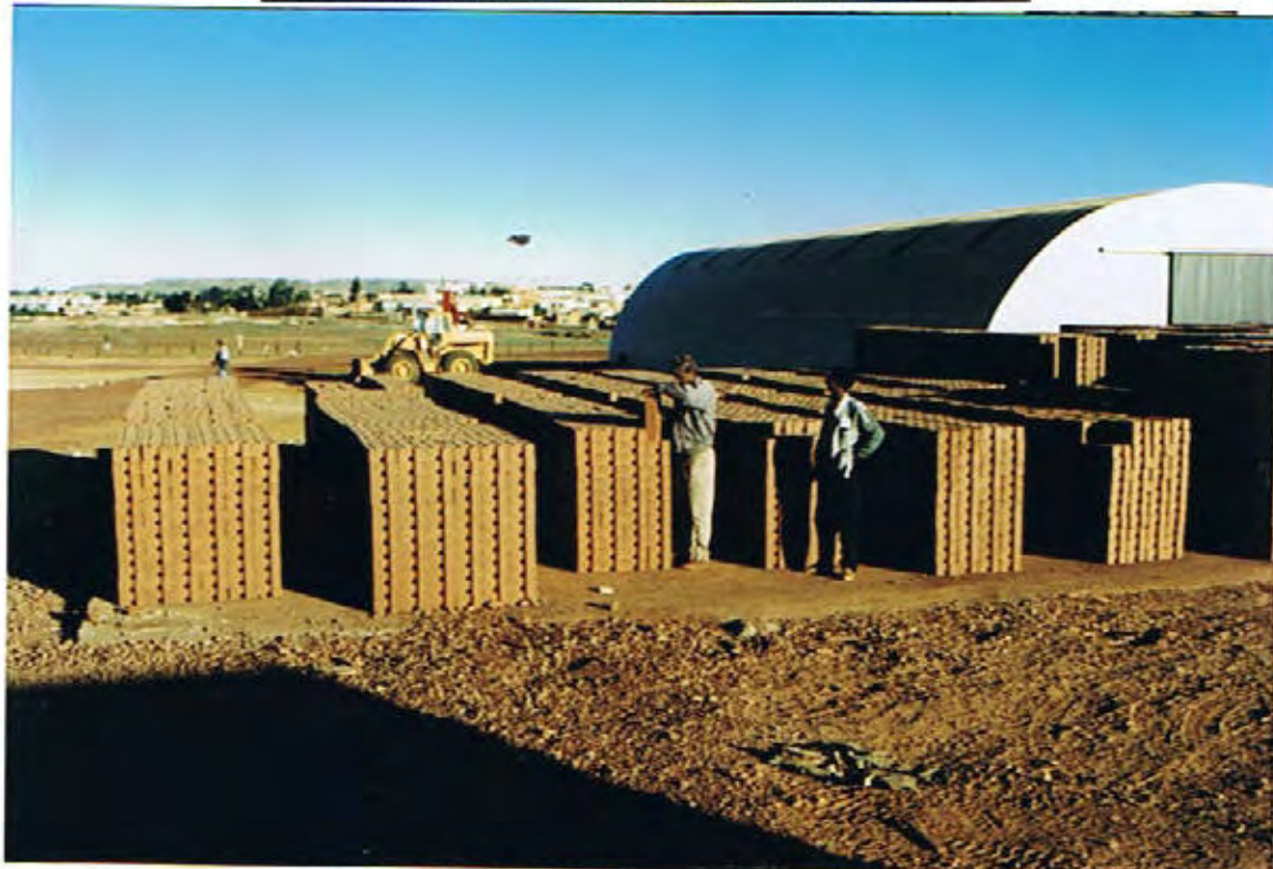
EARTH BLOCKS STOCKING IN EXTERIOR ON 12 ROWS STOCKAGE EXTERIEUR BLOCS EN TERRE SUR 12 RANGÉES
